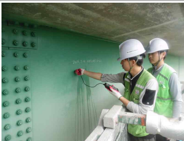
도막두께 측정 (부산방향)
