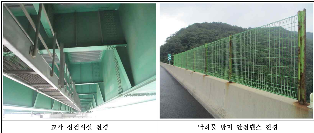
【그림 3-18】 남조천교(부산) 기타 부대시설 전경
