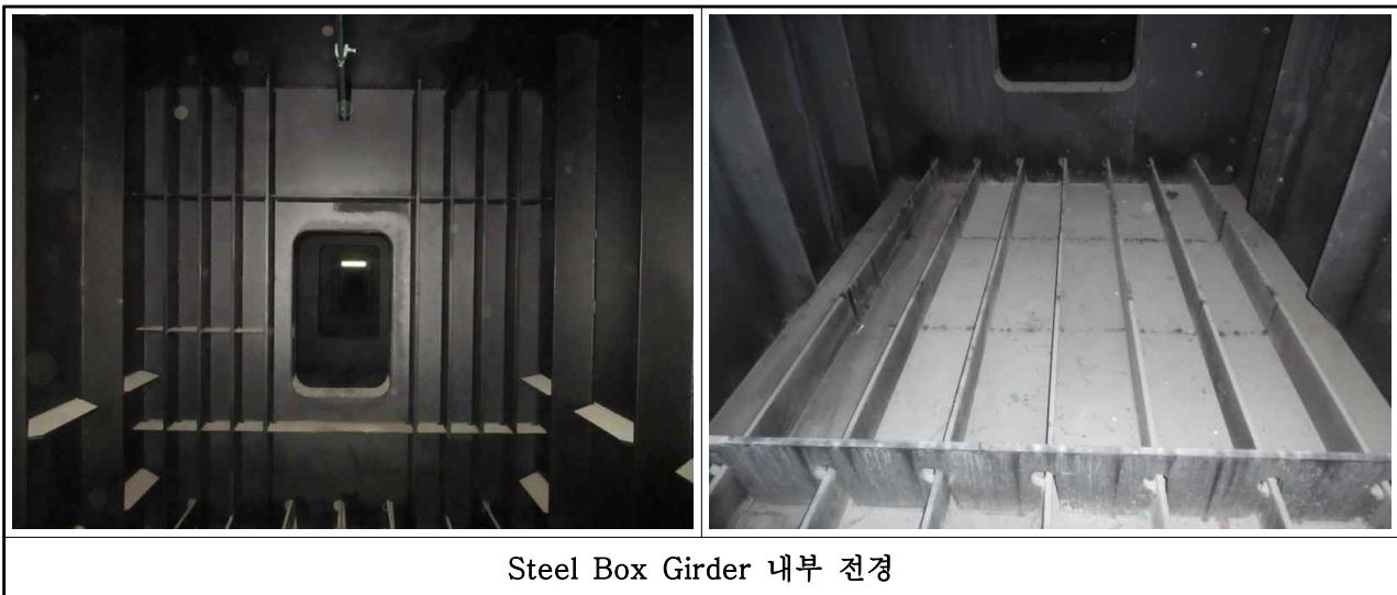
【그림 3-20】 남조천교(춘천) 거더 내부 전경
