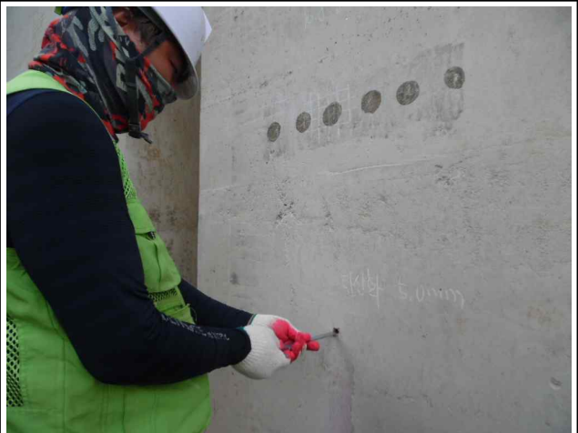
탄산화 깊이 측정
