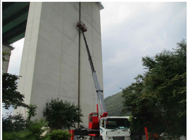
고소작업차를 이용한 외관조사(춘천방향)
