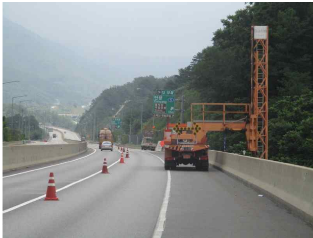
교량점검차를 이용한 외관조사(부산방향)
