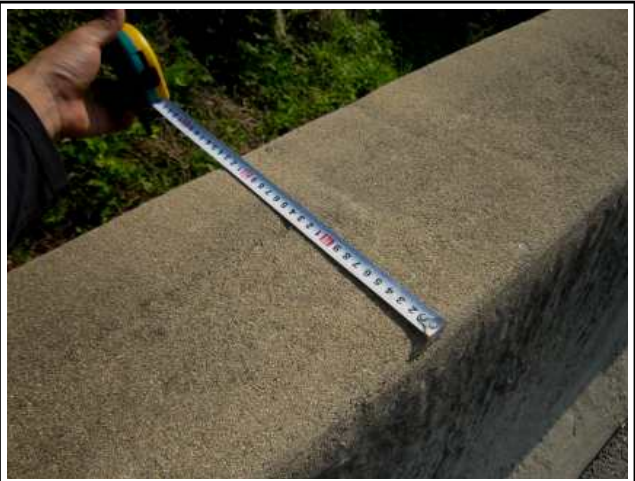
방호벽 제원 측정 현황
