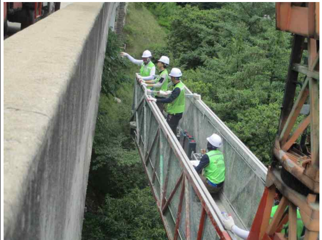
교량점검차를 이용한 외관조사(춘천방향)
