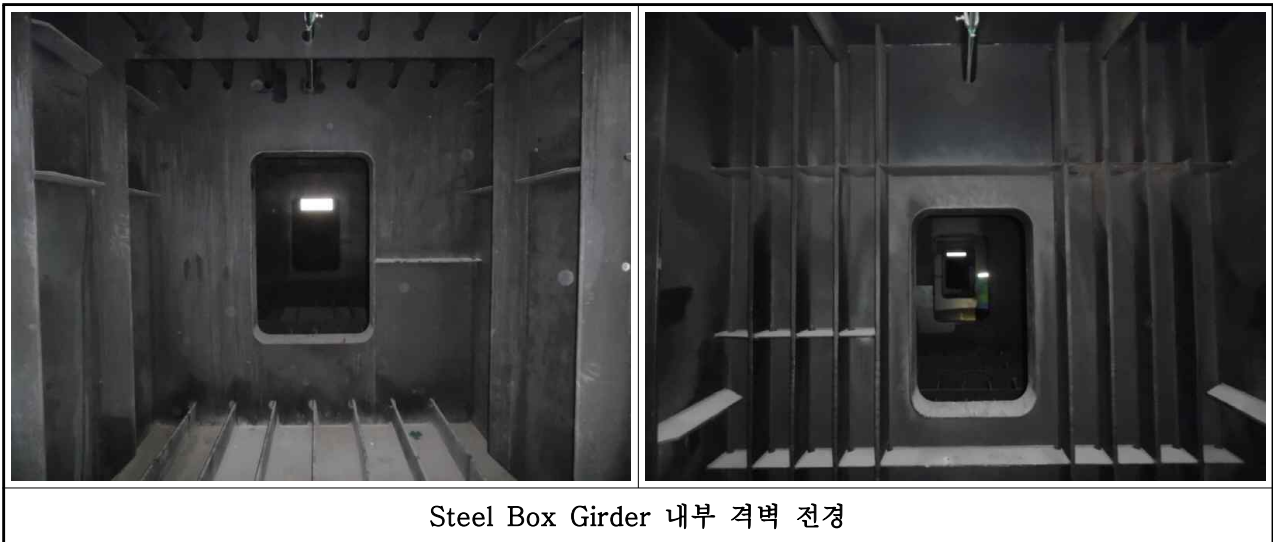
【그림 3-5】 남조천교(부산) 거더 내부 격벽 전경
