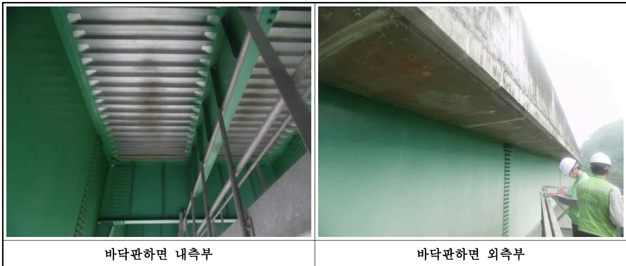
【그림 3-3】 남조천교(부산) 바닥판하면 전경
