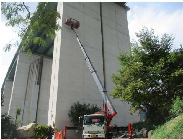
고소작업차를 이용한 외관조사(부산방향)
