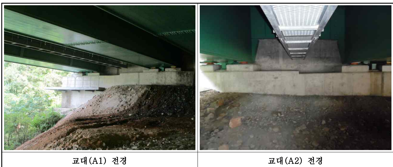
【그림 3-24】 남조천교(춘천) 교대 전경
