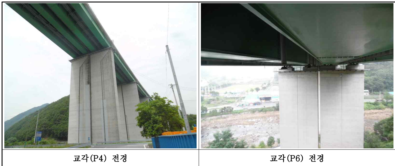
【그림 3-9】 남조천교(부산) 교각 전경
