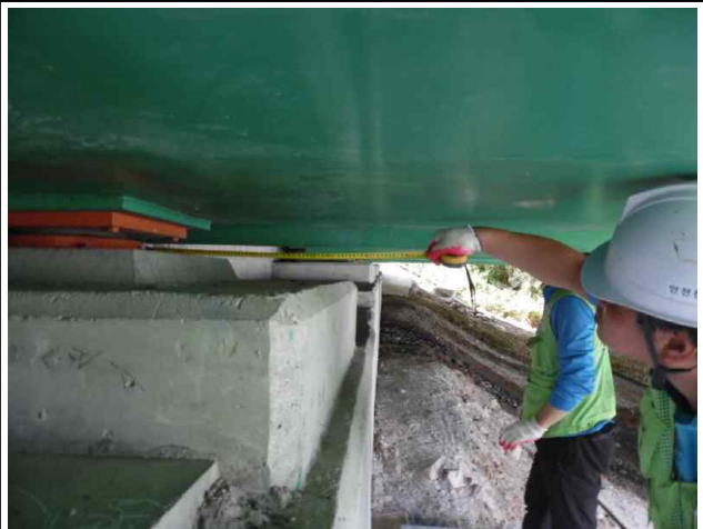
점검로를 이용한 받침장치 외관조사(춘천방향)
