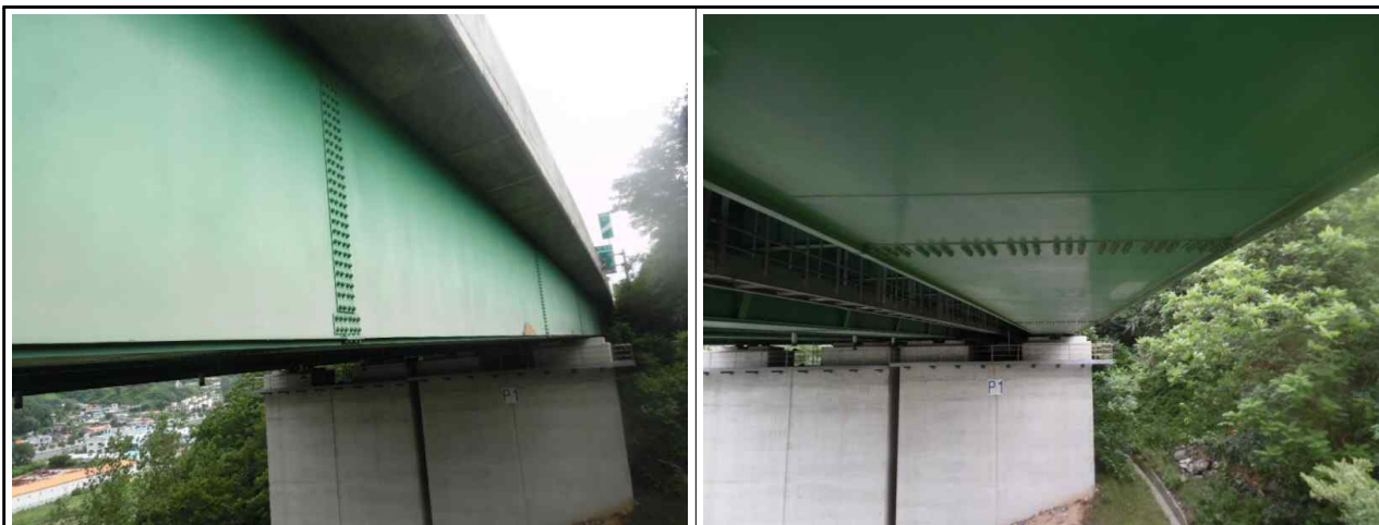
Steel Box Girder 외부 전경
