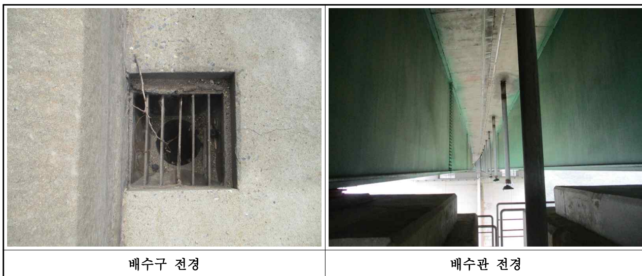
【그림 3-16】 남조천교(부산) 배수시설 전경
