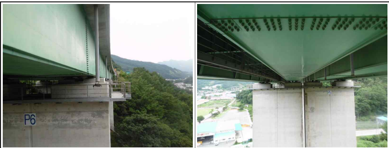
Steel Box Girder 외부 전경
