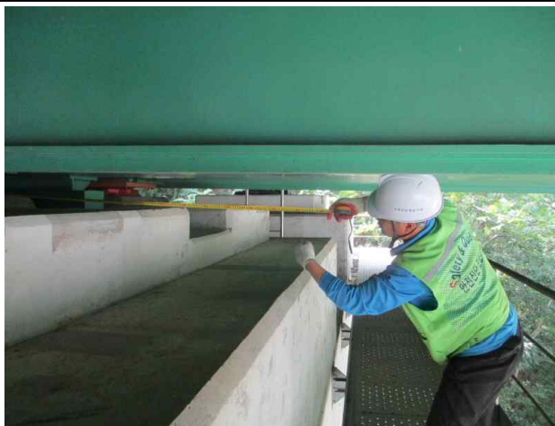
점검로를 이용한 받침장치 외관조사(부산방향) 통풍 안전모 특허 제10-0816556호
