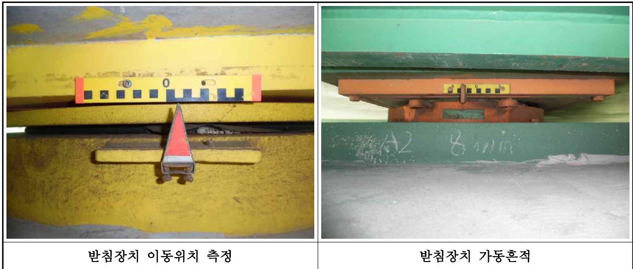
【표 3-12】 부산방향 - 교량받침 가동상태 검토결과
