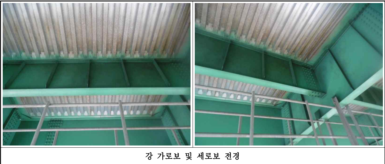
【그림 3-7】 남조천교(부산) 강 가로보 및 세로보 전경
