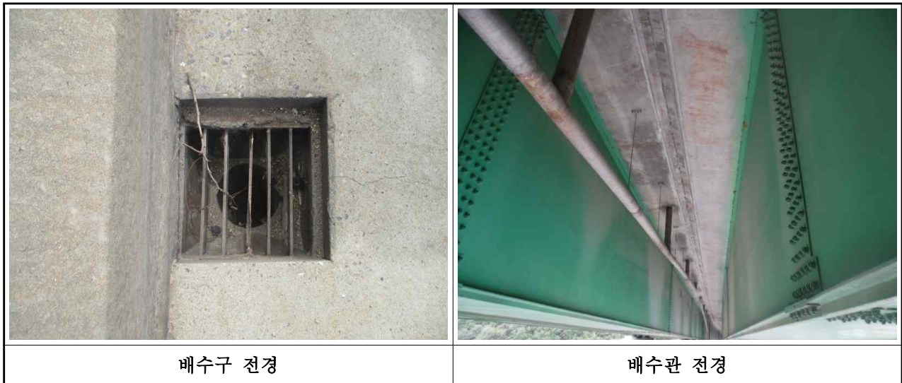
【그림 3-32】 남조천교(춘천) 배수시설 전경
