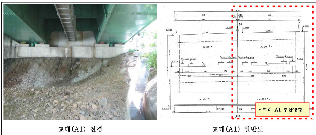
【그림 3-8】 남조천교(부산) 교대 전경 및 일반도
