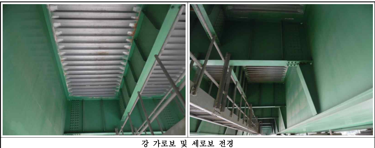
【그림 3-23】 남조천교(춘천) 강 가로보 및 세로보 전경
