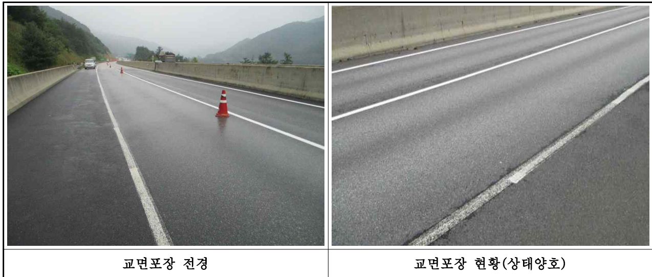
【그림 3-15】 남조천교(부산) 교면포장 전경
